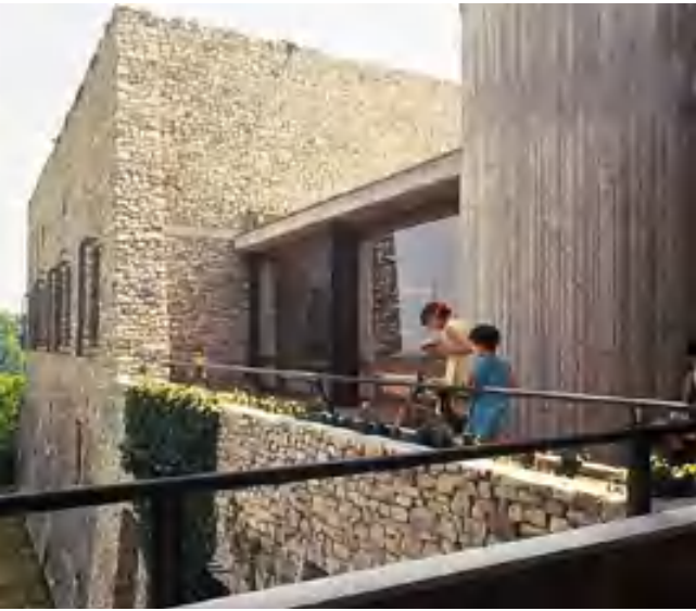
fig. 3 - Connessione tra antica e nuova struttura nel recupero del castello medievale sul colle Muciatella (fotografia Studio Canali Associati).
