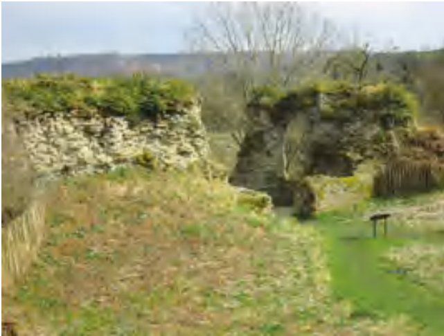
fig. 2 – Vue de la tour est du château de Wigmore (Herefordshire), Monument de l' English Heritage Trust . Les arases de maçonnerie ont été végétalisées au milieu des années 2000 par l' English Heritage avec d'excellents résultats. Un soft capping naturel avait auparavant été retiré en provoquant une détérioration accélérée des ouvrages (Crédits : Fabian Musto, CC-BY-SA, 2018, https://www.geograph.org.uk/photo/5729442 ).
