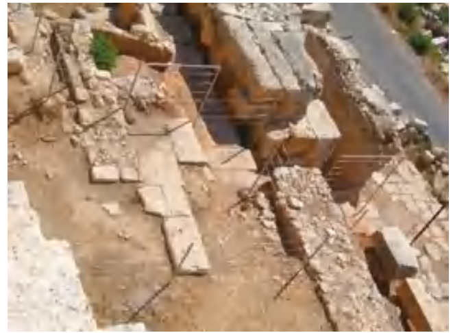
figg.20-21 – Elaiussa Sebaste: i lavori di posizionamento dei tubolari in acciaio con i cavi. Tale sistema, oltre a delimitare gli spazi di fruizione rispetto a quelli ancora interessati dallo scavo, indica i percorsi e le zone di sosta all'interno del monumento.
