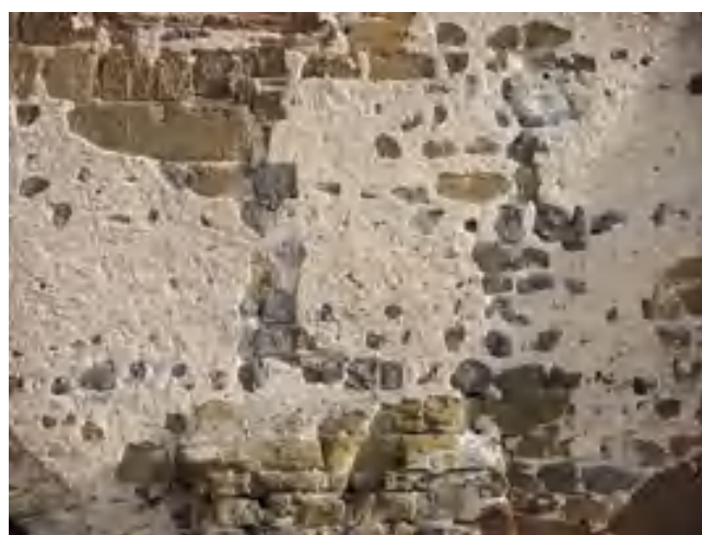
fig. 4 – Chanteuges (Haute-Loire), bâtiments abbaciaux (fin XII e -début XIII e ), crépis « sacrificiels » médiévaux laissant apparaître les remplois et la diversité des appareils et matériaux (Cl. B. Phalip).
