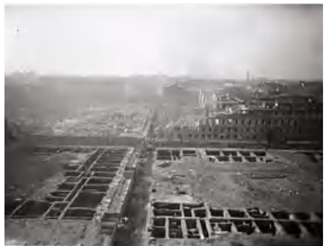
fig. 3 – Veduta aerea dei quattro isolati demoliti tra Piazza San Carlo e Porta Nuova, 10 marzo 1936 (ASCT, Fondo Torino Anni Trenta, FT 08A03_044). Fotografia scattata dalla chiesa di San Carlo verso Porta Nuova.
