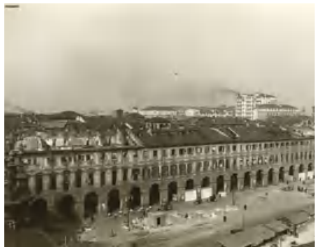
fig. 7 – Piazza San Carlo – Edifici sventrati dai bombardamenti, 1943 (SABAPTo, Archivio Fotografico, n. 1739, ©SABAPTo tutti i diritti riservati). Si notano sull'estrema sinistra le torchiere di coronamento sulla chiesa di Santa Cristina.
