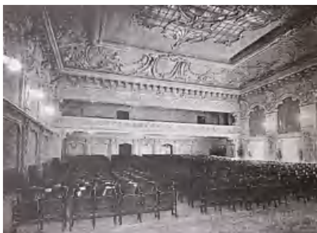
fig. 6 – Vista interna della sala di proiezione dopo l'intervento del 1930 (in IMARISIO, SURACE, MARCELLINO 1996, p. 194).
