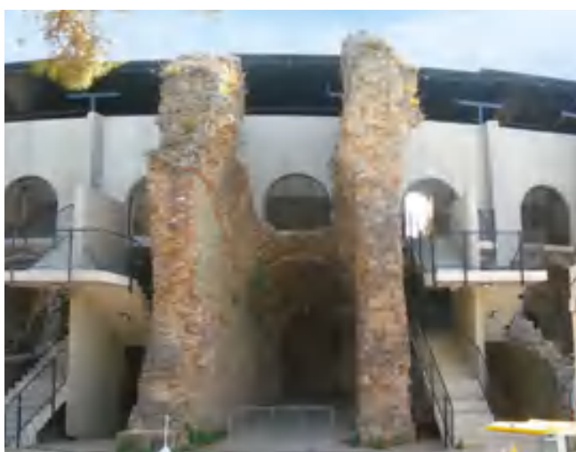
fig. 7 – Fréjus: l'intervento sull'anfiteatro, realizzato dall'architetto Flavigny, per rifunzionalizzare il rudere romano. La soluzione adottata impedisce la lettura dell'edificio originario andando contro ogni ragionevole visione di una corretta conservazione.
