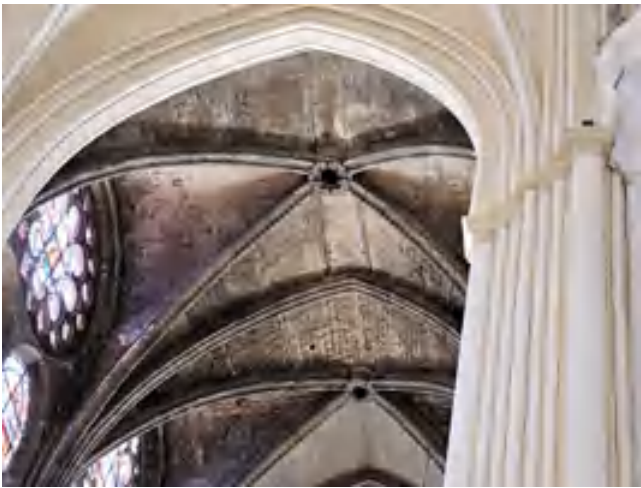
fig. 5 – Notre-Dame de Chartres, chantier de restauration (2015), intrados de voûtes « nettoyés » et badigeonnés, la réalité historique a disparu au profit d'une action « spectaculaire » ; intrados de voûtes non nettoyés montrant les irrégularités, le vieillissement des joints et enduits, les reprises et possédant encore les traces de deux couches distincts de peintures dotés de faux-joints (vers 1220/1230, vers 1270/1280) (Cl. B. Phalip).
