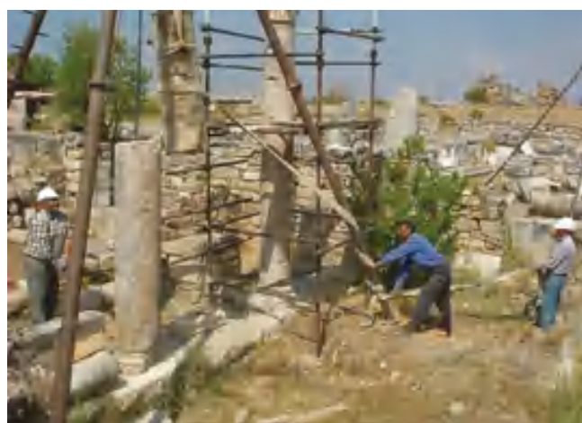
figg. 14-15 – Hierapolis di Frigia: le fasi dell'intervento di ricomposizione meccanica delle colonne del battistero.
