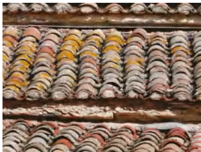
fig. 3 – Aigues-Mortes (Bouches-du-Rhône), couverture du bas-côté sud de l’église paroissiale, moutonnement irrégulier de tuiles vieilles (Cl. B. Phalip).
