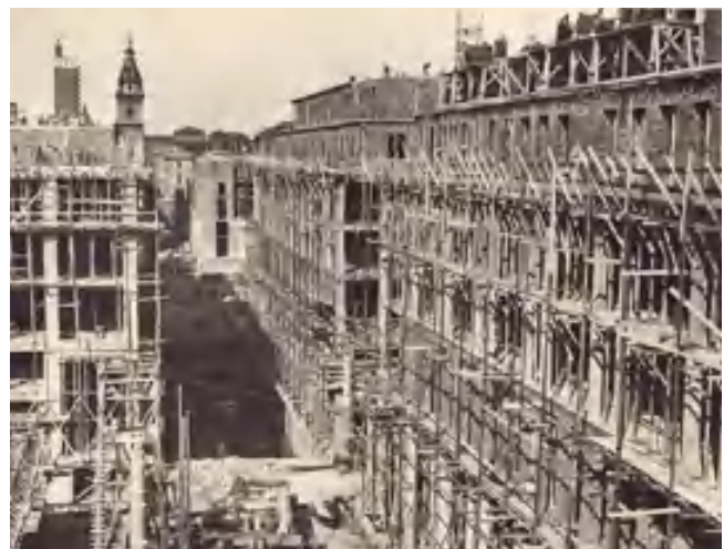
fig. 4 – Cantiere per la ricostruzione di via Roma, 1936 (ASCT, Fondo Torino Anni Trenta, FT 08A04_050). Lo scatto guarda verso piazza San Carlo: si riconoscono il campanile della chiesa di San Carlo e la più lontana Torre Littoria. Si notano anche, in basso a sinistra, le monolitiche colonne dei portici.
