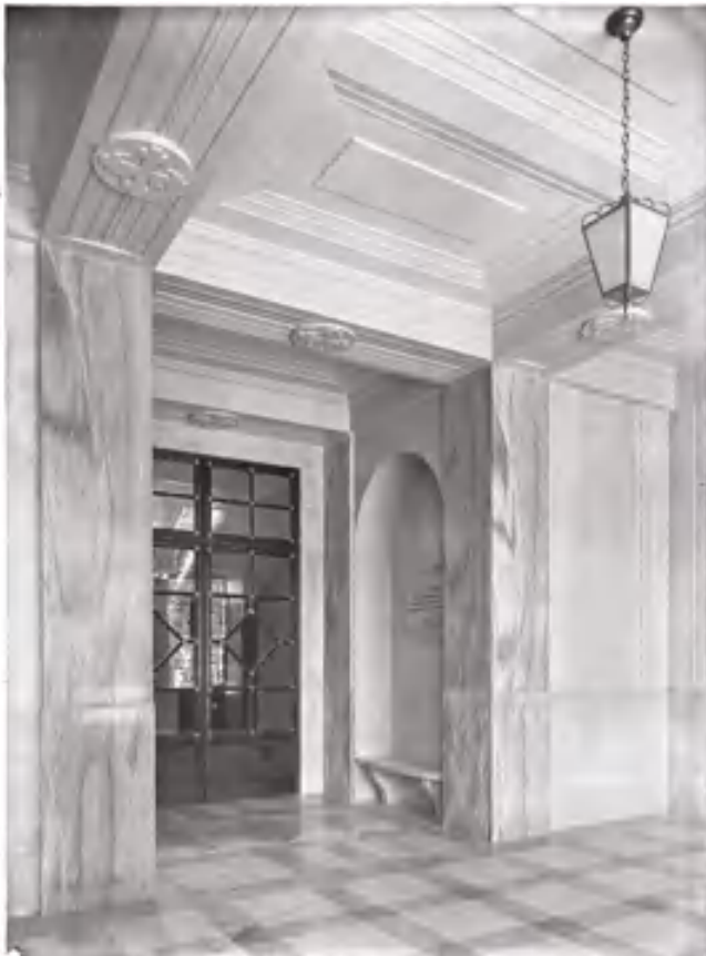
fig. 22 – AUGUSTO PEDRINI, Atrio monumentale e nuovo accesso al complesso ospedaliero , [1931] (AOM, Fondo fotografico , busta 76). Il disegno delle nicchie, delle panche, del serramento della porta, come la selezione dei marmi e la relativa posa sono di Chevalley e corrispondono a tavole e capitolati.
