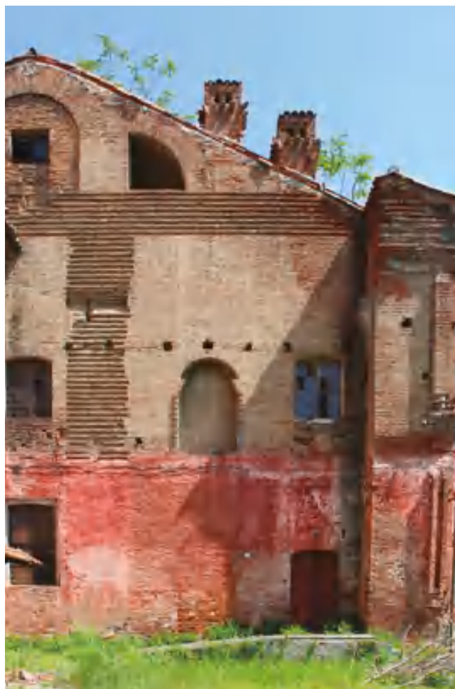
fig. 4 – Prospetto corrispondente alla sezione trasversale della manica sud-orientale rimasta incompleta (fotografia di E. Zanet, 2018).
