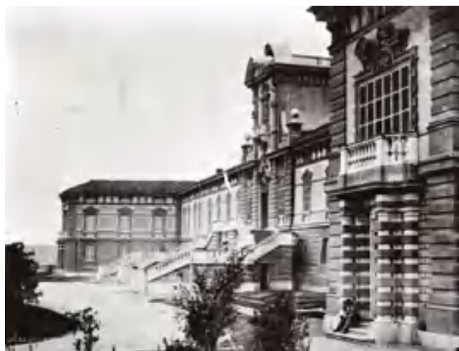
fig. 17 – STUDIO FOTOGRAFIA SUBALPINA, Castello nuovo di Rivara visto da nord est, a lavori ultimati, 1876 circa. (GAM, Gabinetto disegni e stampe , Fondo d'Andrade, 851F).
