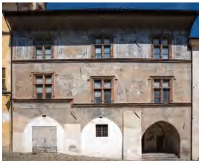
fig. 4 – Facciata di Casa delle Arti, salita al Castello, Saluzzo (fotografia di N. Rivero, 2019).
