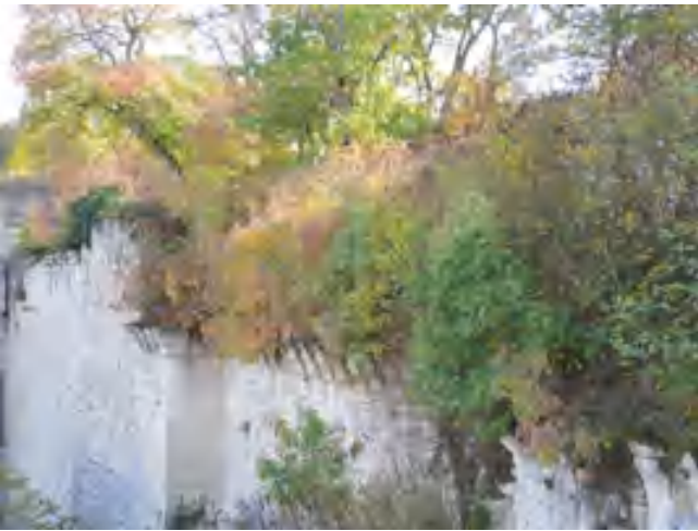
fig. 8 – Chinon (Indre-et-Loire), château, front Nord, rempart couvert d'humus et de végétation depuis deux siècles, abandon au XVI e siècle et transformation en parc en 1824, les racines sont rampantes, les végétaux sont à l'origine d'un paléosol, l'ensemble doit faire l'objet d'une surveillance attentive et d'un jardinage des ruines ; cet équivalent naturel du soft capping possède une résistivité plus forte que la pratique du hard capping avec reprise maçonnerie du sommet des murs (Cl. B. Phalip).
