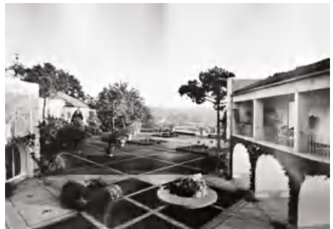
fig. 3 – Il patio e il giardino delle rose in una fotografia attribuibile ad Astolfo Ottolenghi, 1966 (Camaioere, Archivio Ottolenghi Wedekind). Si notino i ragionati allineamenti e la progressione scalare delle geometrie degli ambienti esterni, che incorporano nella composizione il paesaggio della collina acquese, inquadrato dall'architettura del patio come un boccascena. Il documento è fondamentale testimonianza del cantiere – qui appena concluso – condotto da Porcinai.
