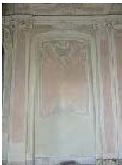
figg. 26 e 27 – Parete est: la riproposizione di arriccio, poi di intonaco e finitura laddove si è rimossa la porta (foto Chiara Ceriotti, 2015).
