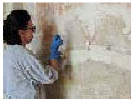
fig. 15 – Consolidamento dei distacchi tra gli strati preparatori (foto Chiara Ceriotti, 2015).
