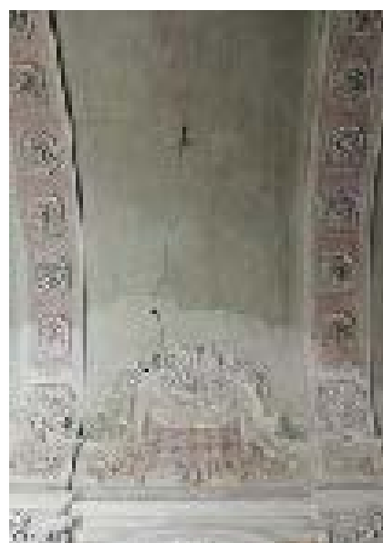
fig. 12 – Gora formatasi sulla volta (foto Chiara Ceriotti, 2015)
