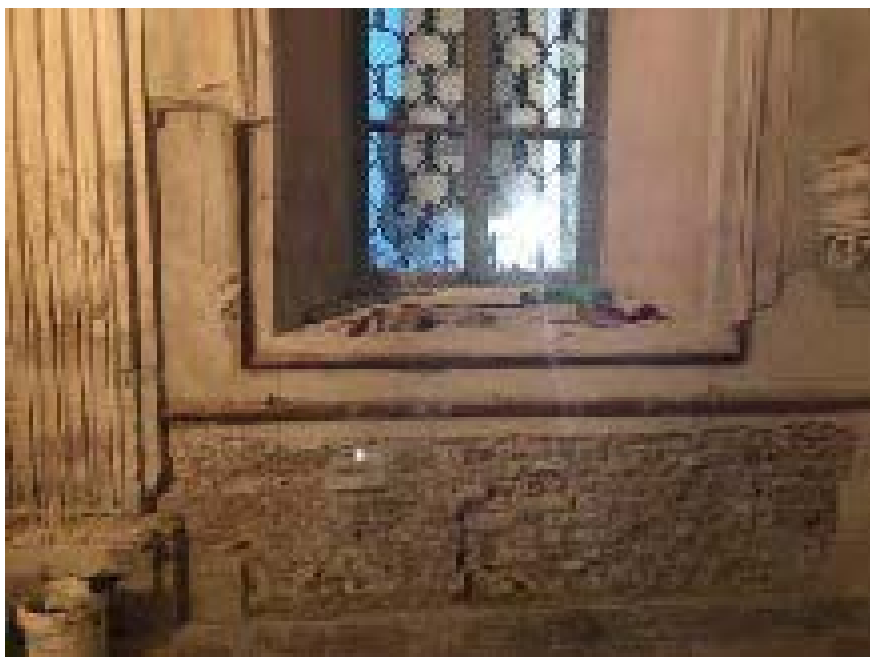
fig. 16 – Armature in laterizio per la realizzazione delle decorazioni (foto Luca Malvicino, 2022).
