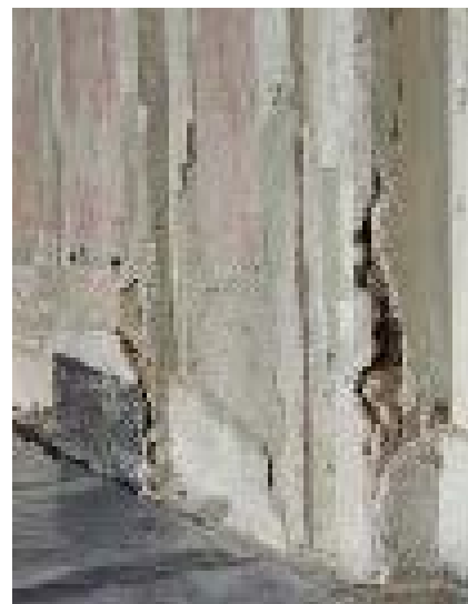
fig. 5 – la porta inserita demolendo parte della specchiatura sulla parete est (foto Chiara Ceriotti, 2015).
