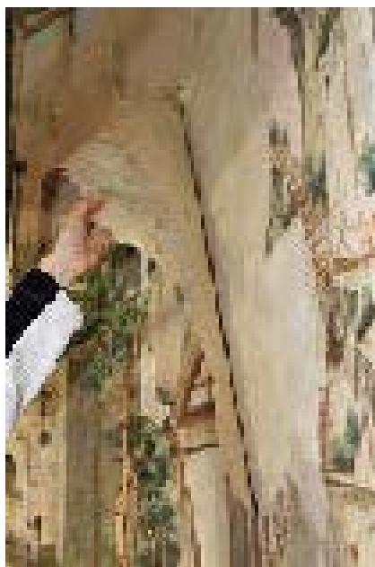
fig. 41 – «Galleria alla China», entità di alcune decoesioni delle carte dall'intonaco, 2015.
