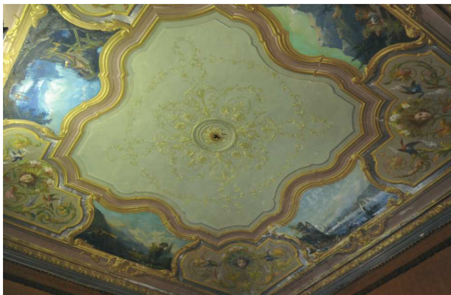
Fig. 8_Soffitto di un ambiente di villa Savoia Carignano, 2010 (foto di Dino Capodiferro). Le decorazioni riprendono uno dei disegni di progetto conservati in archivio (MC_697b).
