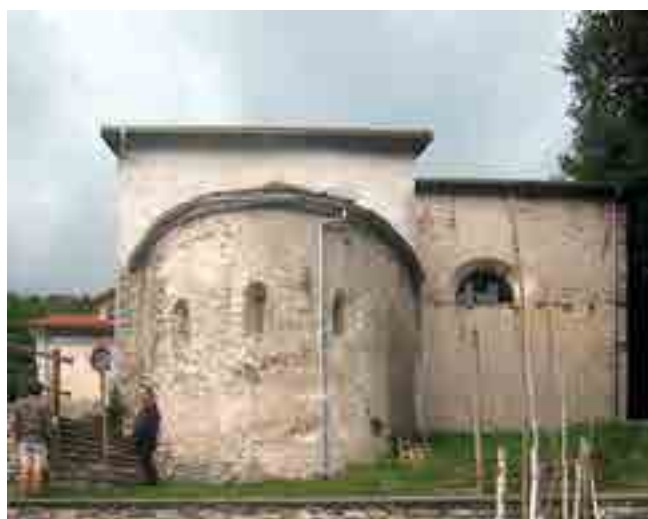
fig. 9 – Ormea (CN), loc. Albareto. Madonna delle ciliegie. Impianto medievale absidato, coperto con doppia falda ruotata di 90 gradi, come per la chiesa minore dei Santi Giulitta e Quirico di fase 2.
