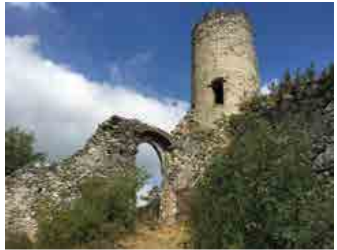
fig. 2 - Torre del ricetto e ingresso, lato interno.
