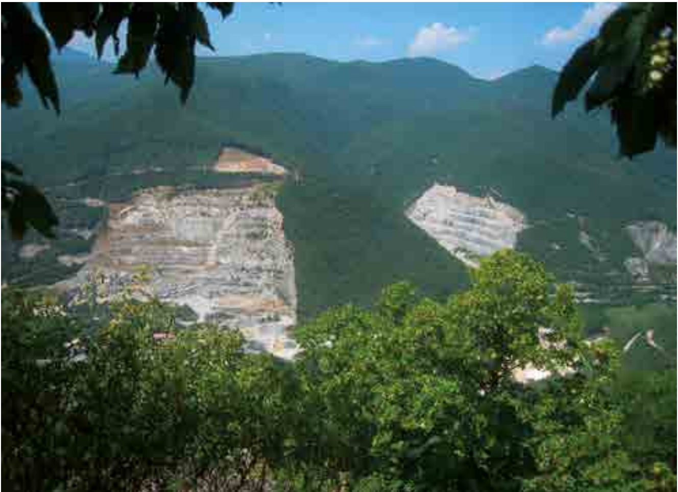
fig. 1 – Bagnasco (CN). In corrispondenza della chiusa di fondovalle, ai piedi del sito di Santa Giulitta, sono attive alcune grandi cave che con un notevole impatto ambientale sfruttano, su entrambi i versanti, la dolomia stratificata per la produzione di aggregati e leganti.
