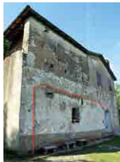
fig. 4 – Bagnasco (CN), chiesa minore dei Santi Giulitta e Quirico. Parete nord dell'antica cappella, con i capichave a paletto dei tiranti, individuabile nel fronte odierno del complesso.
