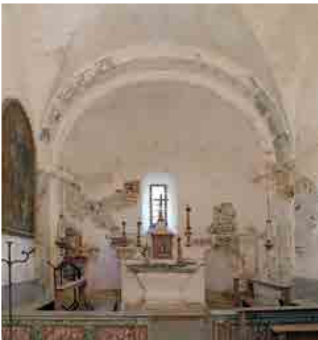
fig. 7 – Casotto (CN), chiesa di Santa Maria e Beato Guglielmo. Arco strutturale in pietra indipendente dalla volta del catino absidale, su pianta circolare a sezione a pieno centro approfondito.
