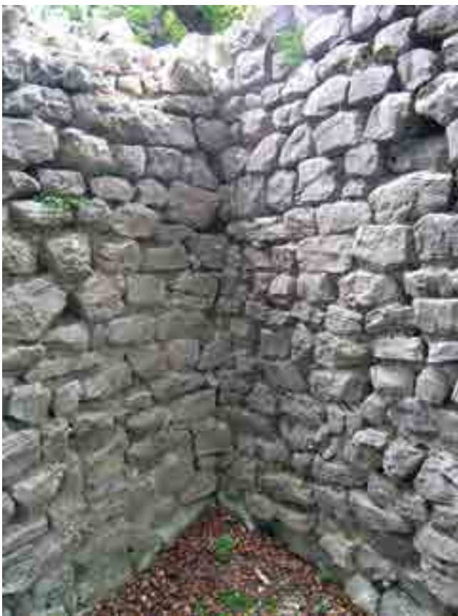
fig. 14 – Immorsamento delle murature della cortina nord-est e della torre (USM 3012 e 3009): insieme e dettaglio.
