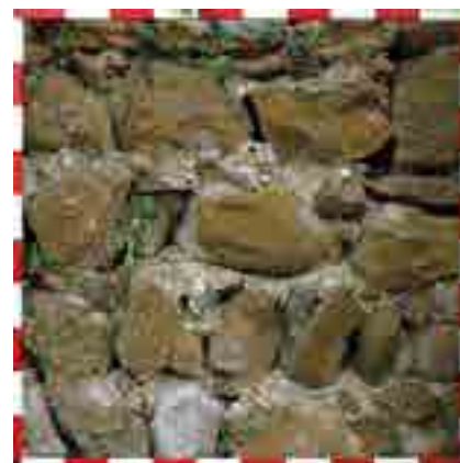
fig. 7 – Paramento murario di scarpa del castello.
