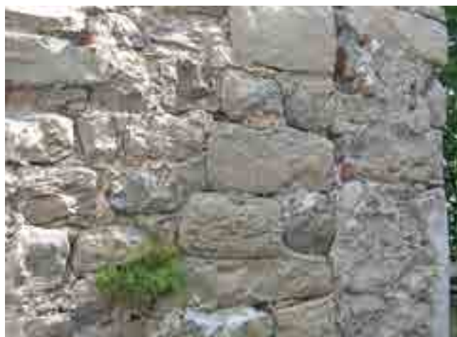
fig. 22 – Parete sud della cappella. Linea di accostamento delle due murature di epoche diverse.
