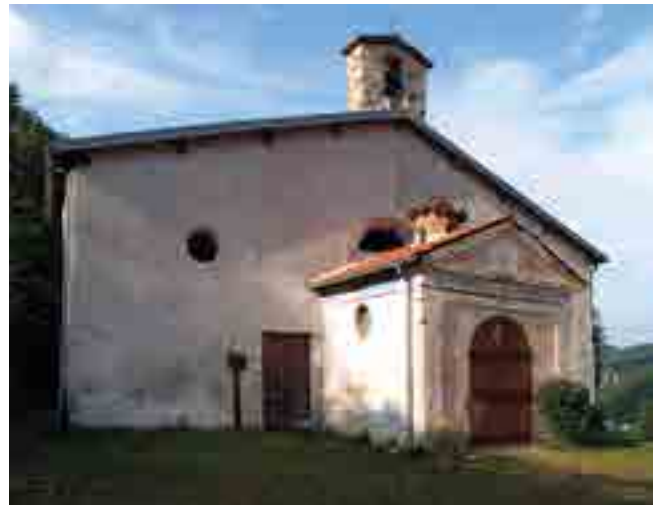
fig. 32 – Ormea (CN), loc. Albareto. Madonna delle ciliegie. Fronte, con finestra a profilo semicircolare di XVII secolo e copertura a doppia falda ruotata di 90 gradi, come per la chiesa minore dei Santi Giulitta e Quirico di fase 2.
