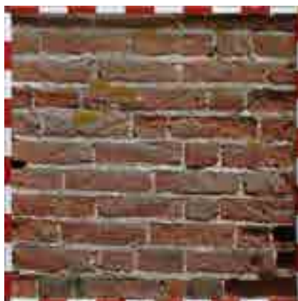
fig. 9 – Paramento murario della struttura interna al castello.
