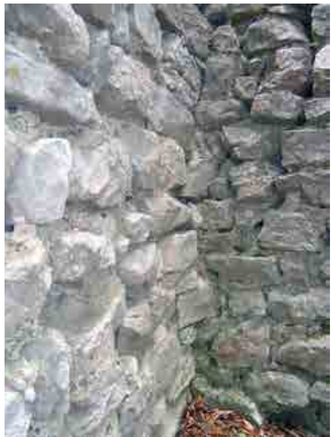
fig. 14 – Immorsamento delle murature della cortina nord-est e della torre (USM 3012 e 3009): insieme e dettaglio.
