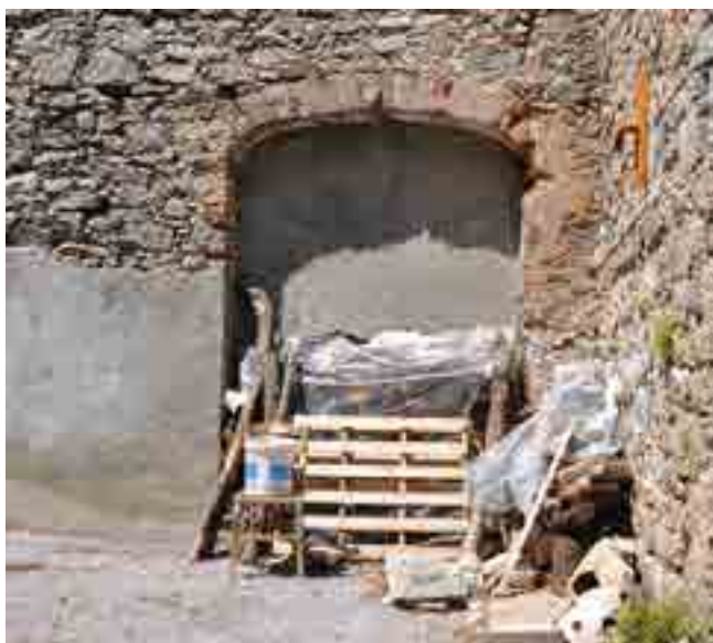
fig. 18 – Parete est della chiesa, in cui si legge l’ingombro dell’ingresso tamponato negli anni ‘60 del ‘900.
