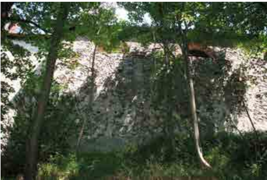
fig. 6 – Chiesa grande: i complessi magisteri murari, con evidenti aperture tamponate, sul fianco ovest.
