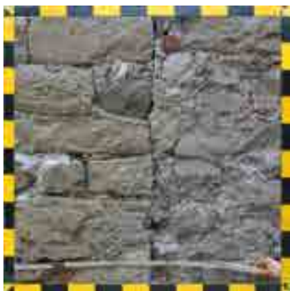
fig. 21 – Parete nord della cappella. Linea di accostamento delle due murature di epoche diverse, emersa attraverso l'intonaco a causa delle spinte orizzontali della cappella.
