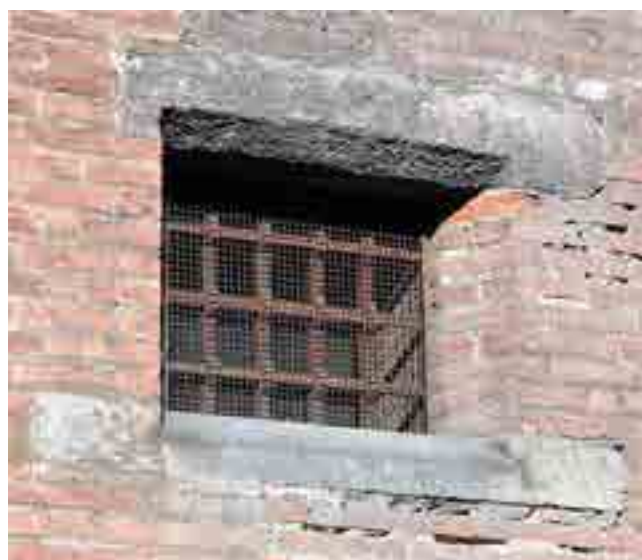
fig. 27 – Torino (TO), castello Acaja, fronte est. Apertura di XV secolo con antica inferriata
