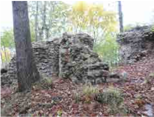
figg. 1 e 2 – Lo stato di conservazione delle murature in corrispondenza della porta: crolli, vegetazione infestante, patina biologica e depositi superficiali hanno reso difficoltoso il riconoscimento e il campionamento dei grumi di sola calce.
