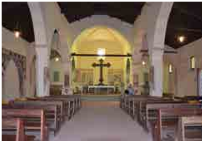
fig. 39 – Millesimo (SV), Santa Maria fuori le mura. Si notano il profilo interno a capanna e archi leggermente ribassati di campate e presbiterio.
