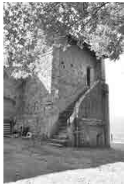
fig. 3 - Lato est. L'area dell'abside con la scala soprastante e i contrafforti di sostegno alla sopraelevazione.
