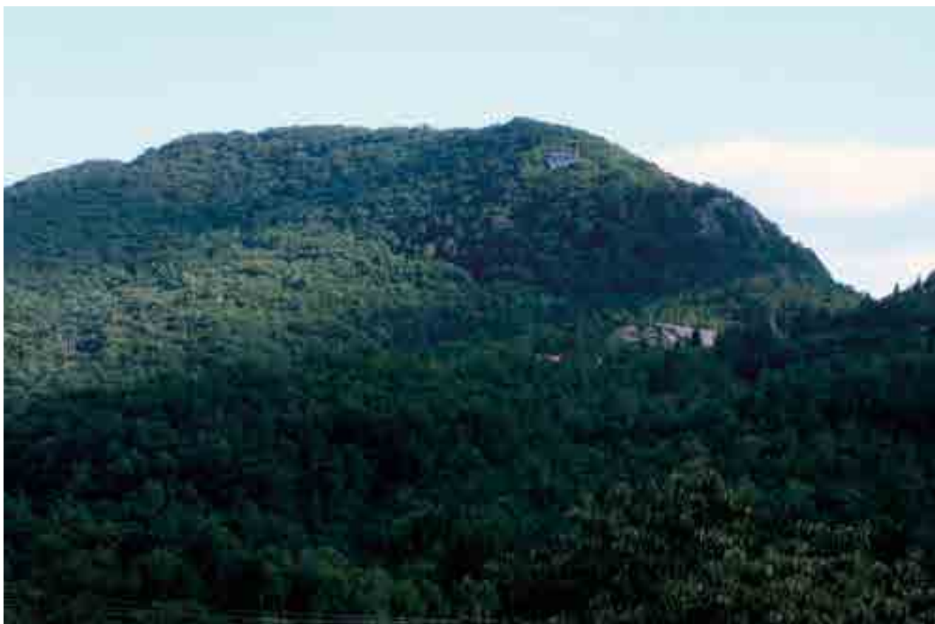
fig. 10 – Bagnasco (CN), Santa Giulitta. Il sito di Santa Giulitta visto dal paese di Bagnasco. Al centro, dall'alto, la cima della torre e il sottostante versante molto acclive.
