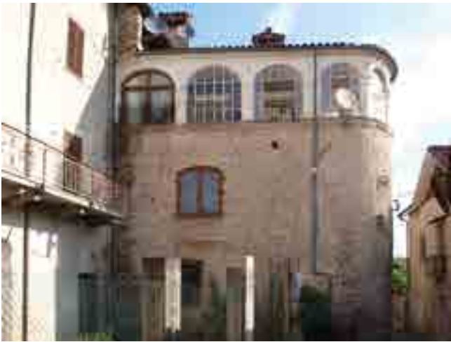
fig. 1 - Torre inglobata nell'edificio residenziale.
