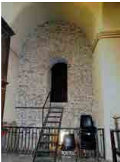
fig. 10 - Parte del campanile interno.
