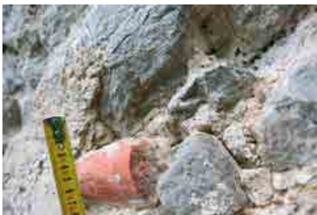
figg. 20, 21 – Bagnasco (CN), chiesa maggiore dei Santi Giulitta e Quirico. Fronte ovest: frammento reimpiegato di laterizio con sagoma a mezzo toro.
