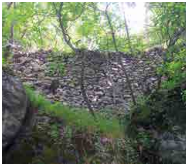
fig. 21 – Cortina sud-ovest (Area 4), tratto a monte con tessitura più disomogenea.
