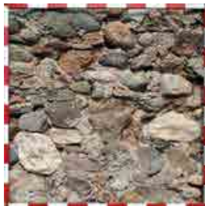
fig. 4 - Paramento murario del ricetto.
