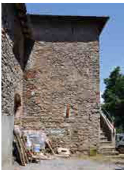
fig. 13 – Esterno della parete sud.
