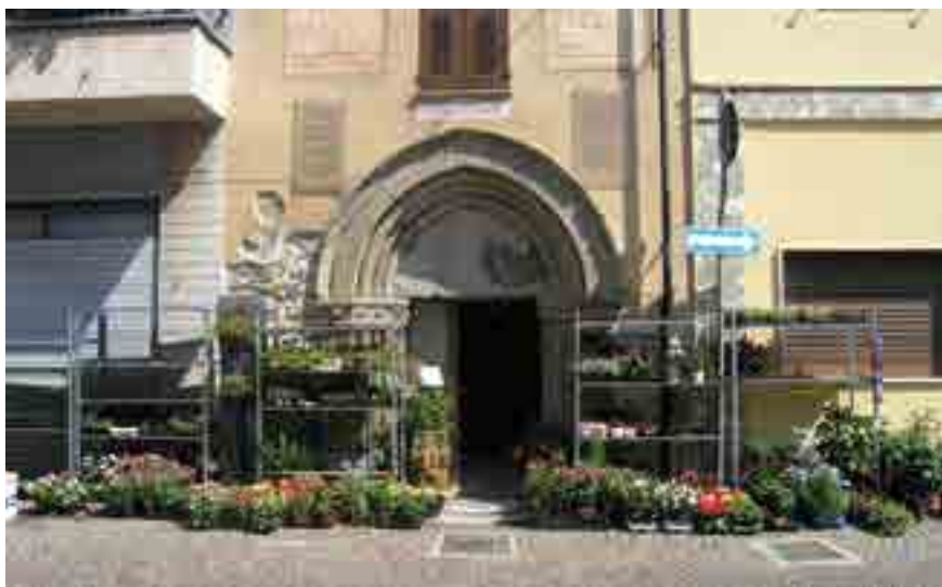
fig. 8 - Portale d'ingresso di San Giovanni.
