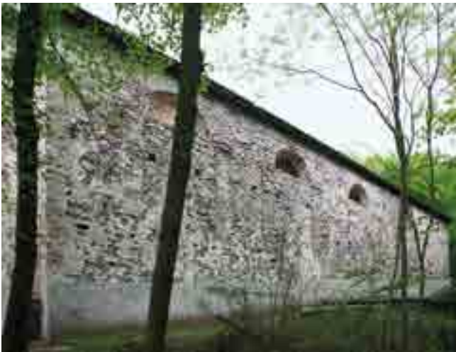
fig. 5 – Bagnasco (CN), chiesa maggiore dei Santi Giulitta e Quirico. Fronte di ponente, con tracce delle aperture tamponate.
