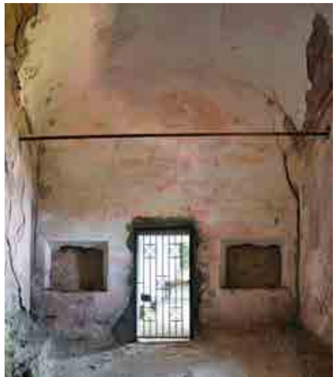
fig. 9 – Cappella dei Santi Giulitta e Quirico (Area 1), controfacciata.
