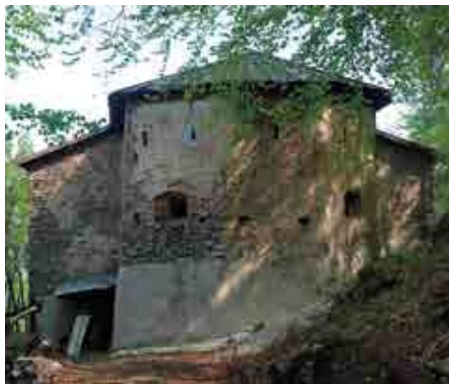
fig. 29 – Bagnasco (CN), chiesa maggiore dei Santi Giulitta e Quirico. Fronte sud, area absidale.
