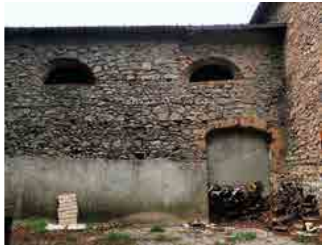
fig. 7 – Bagnasco (CN), chiesa maggiore dei Santi Giulitta e Quirico. Fronte est, con l'antico accesso dell'edificio adiabasico di fase 2, successivamente modificato e infine murato.
