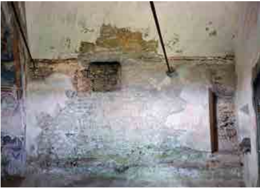
fig. 14 – La parete meridionale della cappella.
