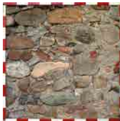
fig. 10 – Paramento murario della struttura interna al castello.
