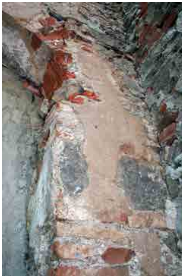
fig. 8 – Dettaglio del fronte di levante: la spalla di un'apertura ora occlusa, con lacerti di intonaco a calce e l'accostamento di murature di fasi differenti.
