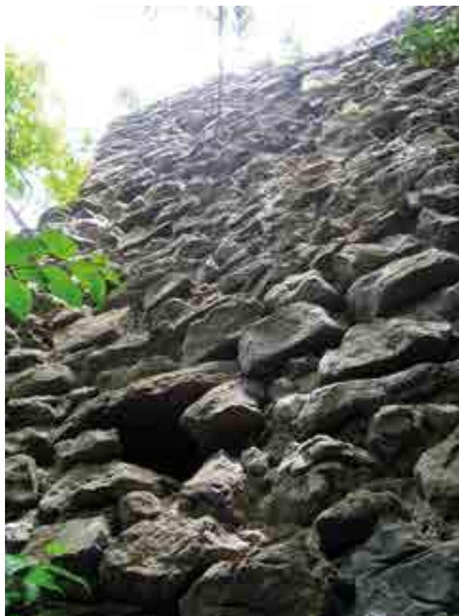
fig. 22 – Cortina sud-ovest (Area 4), tratto a valle realizzato con maggiore cura e con buche puntaie.
