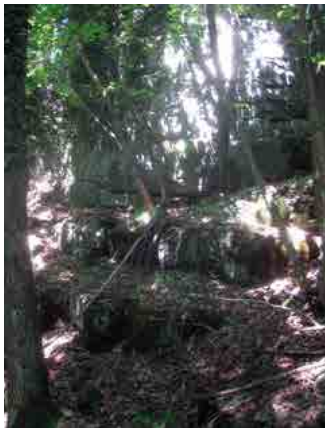
fig. 8 – Bagnasco (CN), Santa Giulitta. Gradonata in roccia viva alla base della rupe su cui è costruita la torre.
