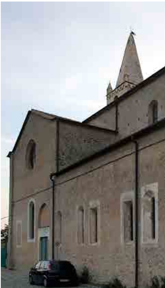
fig. 30 – Taggia (IM), chiesa di San Domenico. Fronte est: aperture binate lungo la navata laterale.
