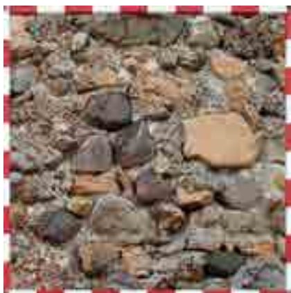
fig. 5 – Paramento murario della torre superiore del ricetto.
