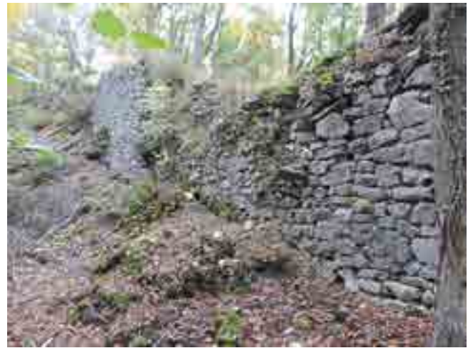
figg. 1 e 2 – Lo stato di conservazione delle murature in corrispondenza della porta: crolli, vegetazione infestante, patina biologica e depositi superficiali hanno reso difficoltoso il riconoscimento e il campionamento dei grumi di sola calce.
