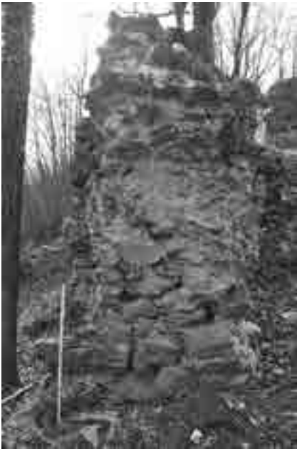
fig. 6 - Dettaglio degli elementi lapidei componenti la struttura muraria in corrispondenza dell'arco (Giani, 2017).
