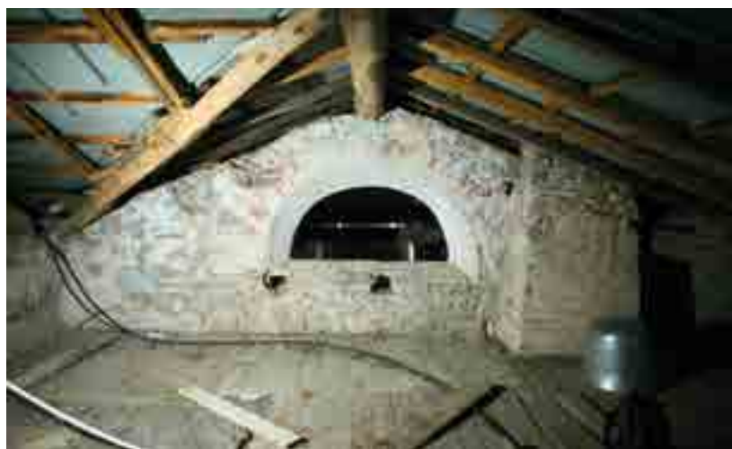
fig. 16 – Bagnasco (CN), chiesa maggiore dei Santi Giulitta e Quirico, antica facciata, lato esterno. Finestra a profilo semicircolare di fase 3, oggi occultata dalla sovrapposizione degli spazi della foresteria.
