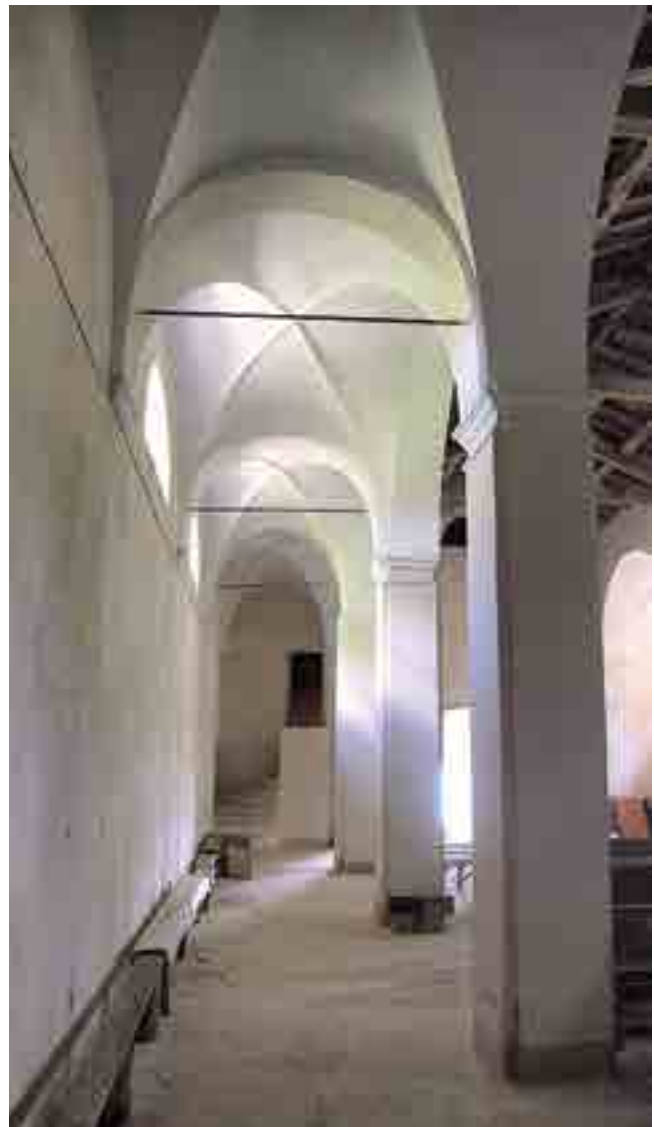
fig. 18 – Bagnasco (CN), chiesa maggiore dei Santi Giulitta e Quirico. Navata laterale destra, con volte a crociera di fase 3 e, in fondo, scala di accesso alla foresteria
