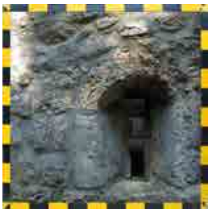
figg. 35-36 – Campione “E” 1m x 1m di tessitura muraria esterna, abside della cappella.
