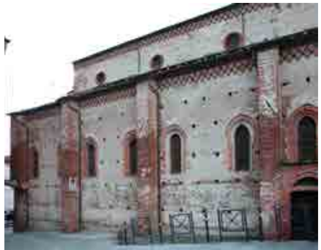
fig. 31 – Revello (CN), collegiata di Maria Vergine Assunta. Fronte nord: aperture binate lungo la navata laterale.
