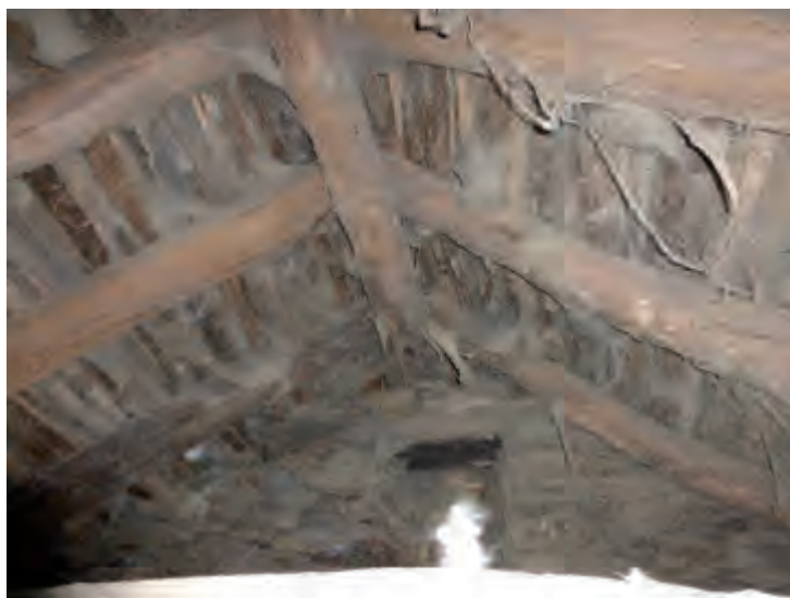
Fig. 9.20 Rovegro. Edificio rustico ancora in uso, con stalla al piano inferiore e fienile al livello superiore. L'interno del fienile, con la struttura a puntoni su dormiente e colmo (visibili anche all'esterno), con correnti molto fitti non formati con elementi pseudo cilindrici, bensì con elementi misti molti dei quali a forma parallelepipeda. L'orditura principale è di larice.
