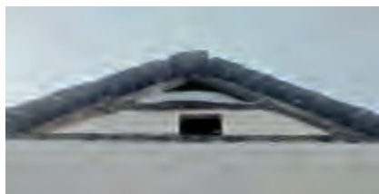
Fig. 9.22 Gurro (Valle Cannobina). Testata di edificio con tamponamento realizzato successivamente (edificio a timpano aperto, originariamente). La struttura del tetto è del genere a capriate con mutuo incastro dei puntoni a mezzo legno e innesto degli stessi sulla catena.
