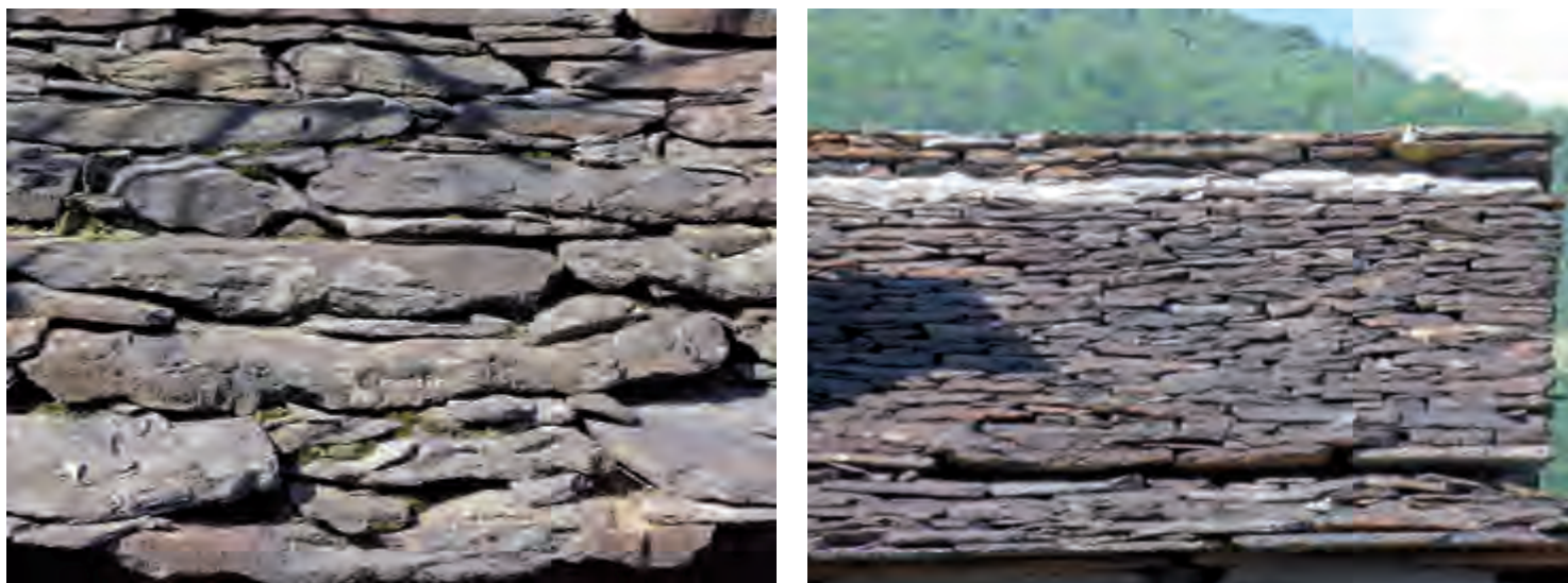
Fig. 9.8 Reimpiego di piode da tetto di grandi dimensioni quali gradini e copertura di un muro di pietra a secco. Su alcuni elementi lapidei permangono segni di lavorazione con attrezzi metallici.
