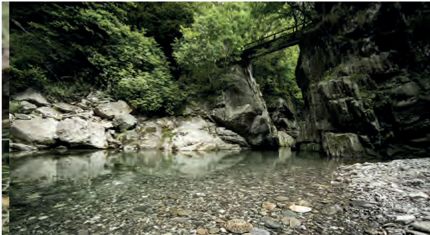
Fig. 1.2 Rio Pogallo, il ponte di Calenesco.
